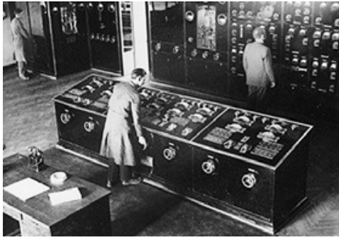
Abb. 1: Die Kontrollkonsolen der technischen Ausrüstung in Junglinster in den frühen 1930er Jahren.
