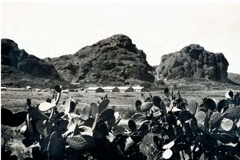
Abb. 7: Militärische Infrastrukturen in der Kolonie Eritrea, Fotografien.
