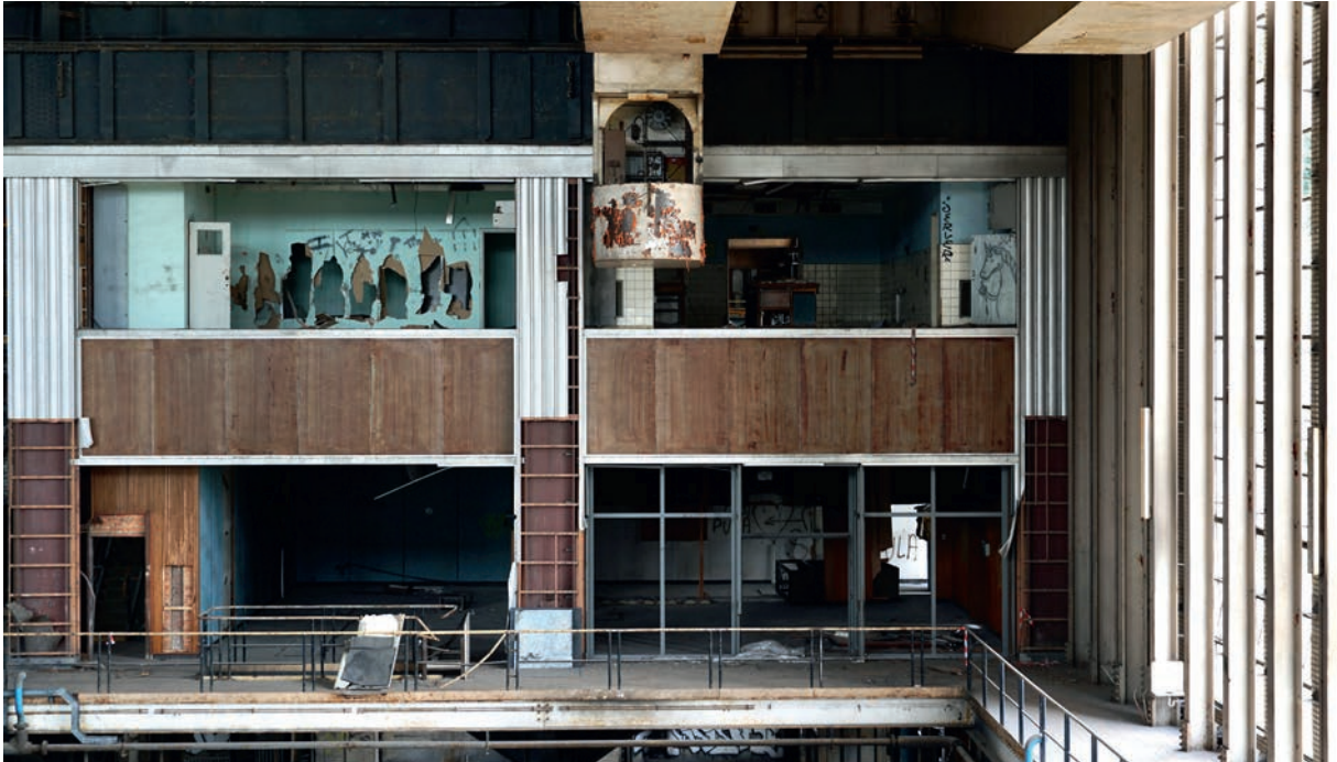
Das stillgelegte Kohlekraftwerk im belgischen Charleroi
